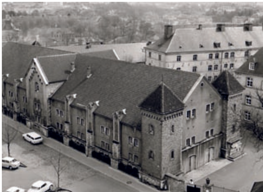
Das Kornmagazin war ein riesiges Lagergebäude (Photothèque de la ville de Luxembourg)
