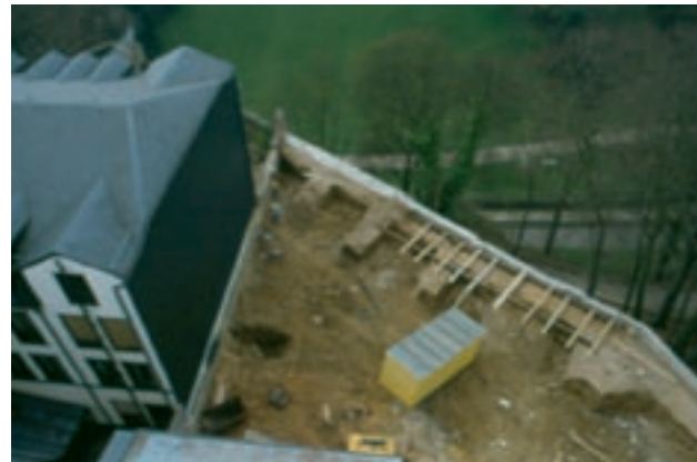
Vor Beginn der Aushubarbeiten. (A. B.)
