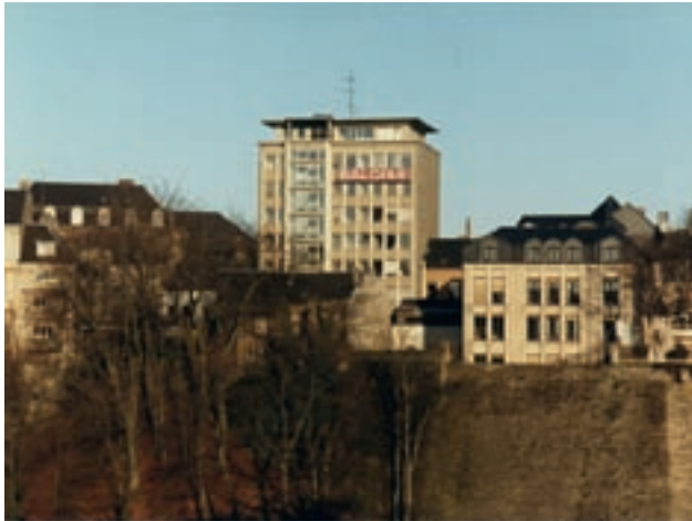
Das Baloisegebäude zur Petrusseite ausgerichtet. (Archiv „La Baloise“, vor 1995)
