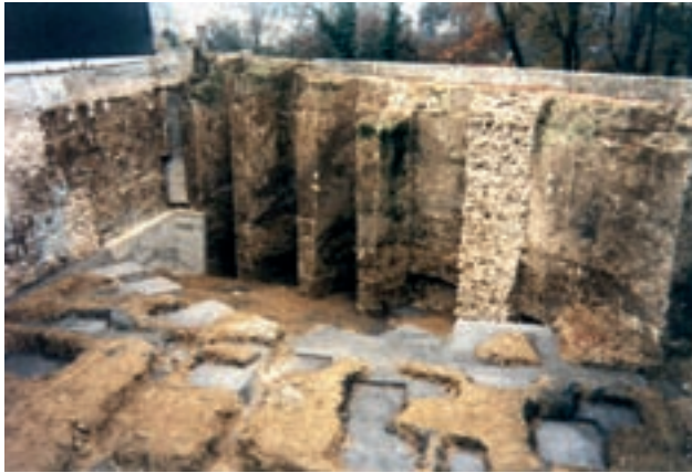
Baugrube und Teil der Bastion Louis.
