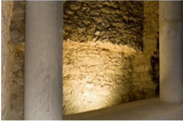
Erhalt und Aufwertung der Bastion. Die Innenwand ist teilweise zugänglich und sichtbar. (LRI)
