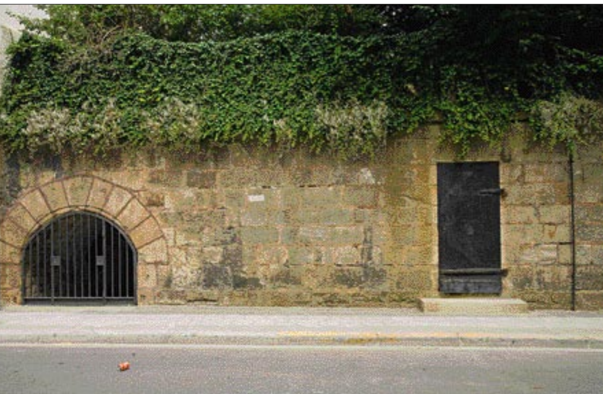
Zugang zur Grundsleuse: Unscheinbar liegen die restaurierten Überreste hinter einer zehn Quader hohen Mauer.
